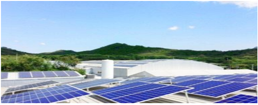
ระบบ Solar Rooftop บนหลังคาโรงงานของบริษัทช่วยลดภาระค่าไฟฟ้าสูงสุด ภาพแสดงการใช้ไฟฟ้าสูงสุดช่วงกลางวันถึง 27,346 เมกกะวัตต์
